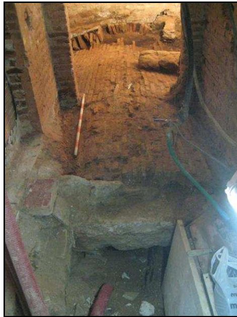
21. Vista NW de la claveguera on s'observa la coberta en volta i el bloc de pedra en el seu extrem SE.
