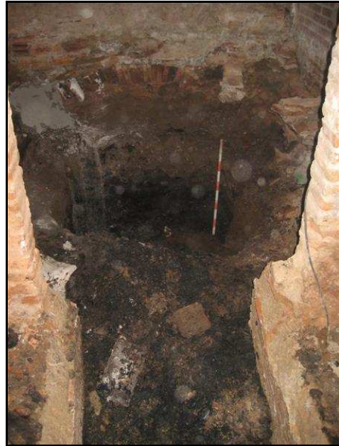
23. Vista NW del fossat d'ascensor
