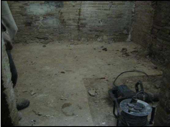
10. Imatge del paviment abans d'iniciar el rebaix
