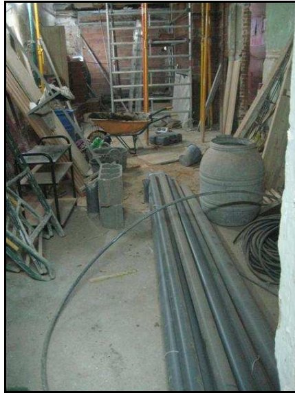
6. Vista SE de la sala adjacent del vestíbul rebaixat i formigonat
