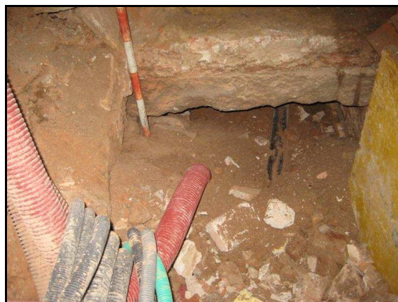
8. Imatge d'un tram de la claveguera
