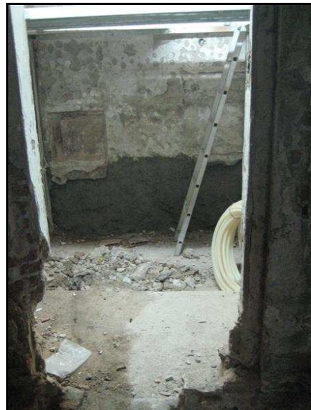
5. Vista NW del fons de la sala adjacent del vestíbul, rebaixada i formigonada
