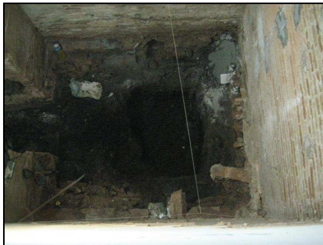
24. Foto final del fossat
