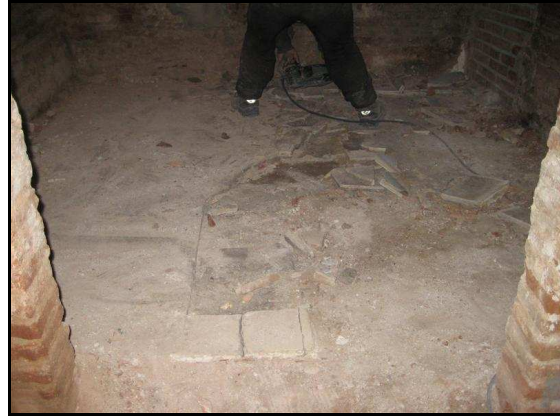
11. Desmuntant el paviment
