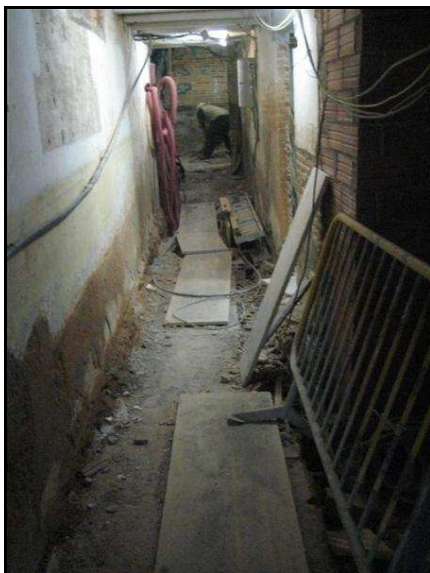
7. Vista NW del vestíbul rebaixat i formigonat
