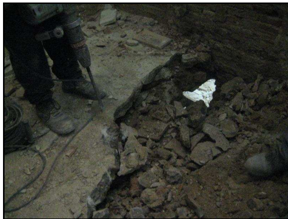
12. Picant la planxa de formigó
